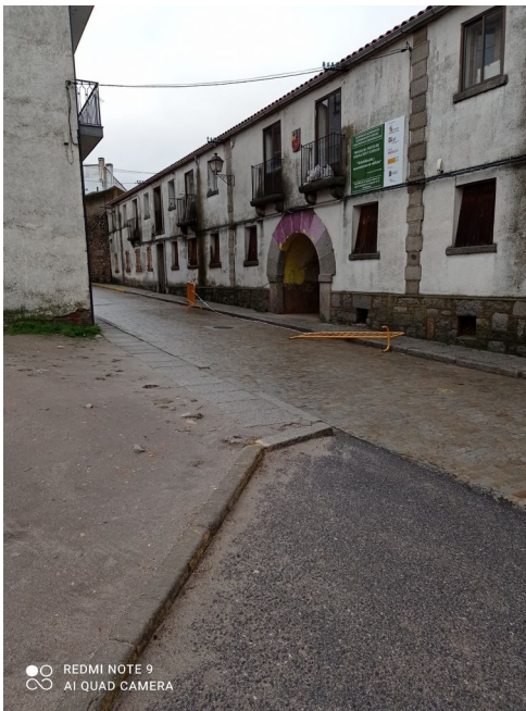
Fachada del edificio a la calle Segovia.
